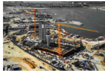
Construction Site Palazzo Versace
