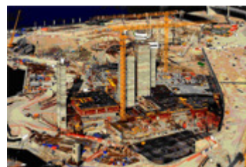
Construction Site Palazzo Versace
